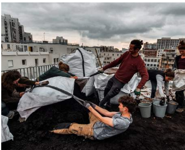
Chantier aménagement - Salamandre - Mars 2022
