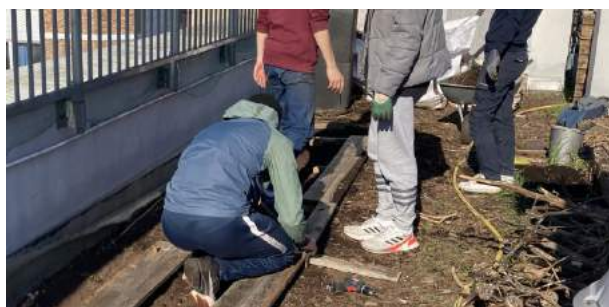
Construction de bacs avec Services Civiques - Tanger - Dec 2022
