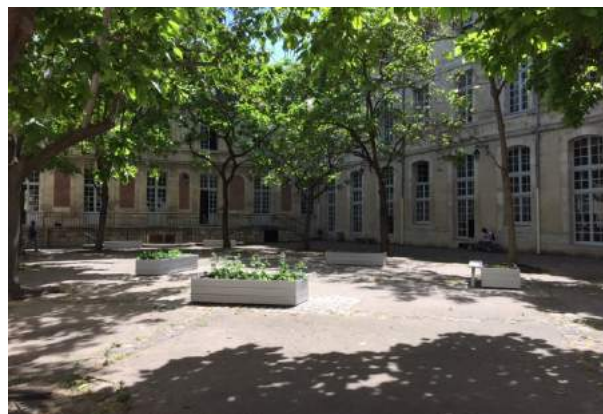
Vue d'ensemble - Lycée Charlemagne - Juin 2022
